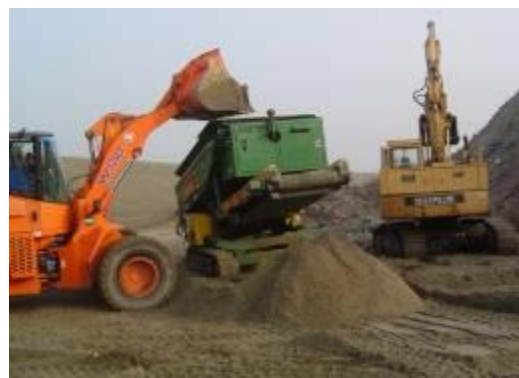
Figura IV.2.3.1.1- operazioni di vagliatura in sito.
