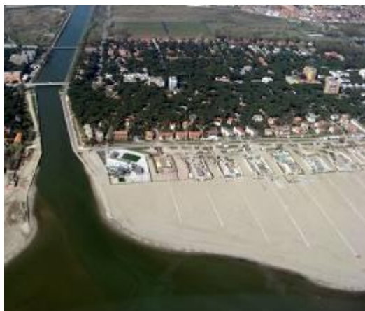
Figura IV.2.3.5.3 – esempio di accumulo sommerso alla foce di un corso d'acqua, il canale al centro deve essere mantenuto di opportuna sezione.
