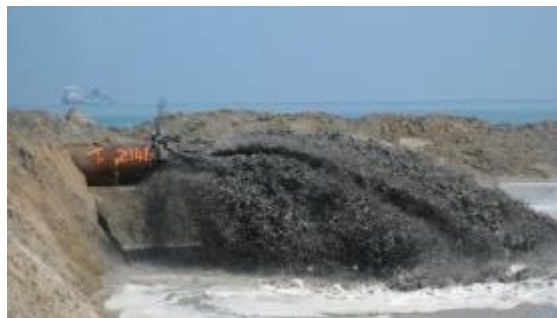
Figura IV.2.3.4.1- ripascimento con sabbie sottomarine
